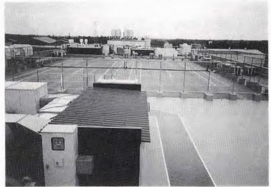
部については、下地押え層とアスファルト防水層の中間部の断熱層（発泡ポリスチレン）に多量の水分が滞留していると思われたため、目地脱気工法を併用した。
