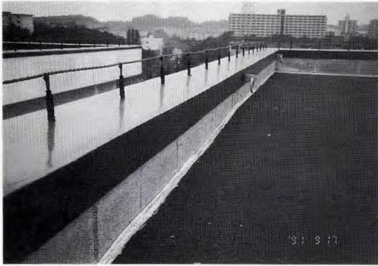
① 屋根断熱防水改修時にパラペット部に塗膜防水
