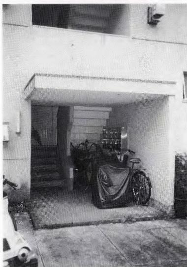
㊧ 中層階段室出入口底天端へ塗膜防水(保全工事として)
