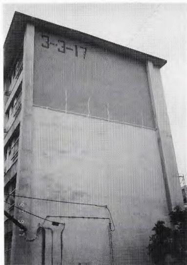
㊨ 外壁のひび割れに塗膜防水
