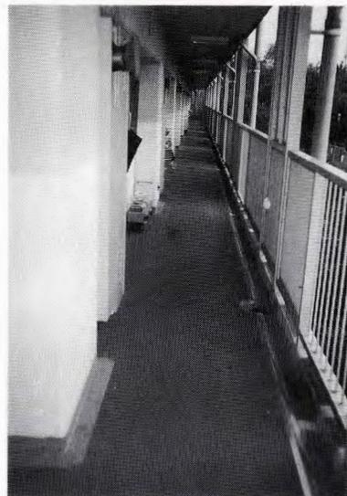
㊩ HPC工法廊下に塗膜防水
