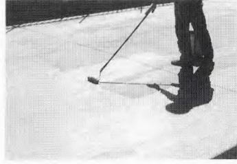
写真-5 コンボトップAU塗布仕上げ
