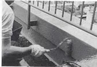
写真-9 立上り用防水材(C) 塗布
