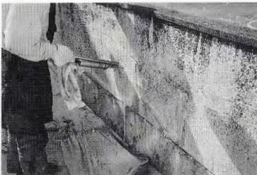
写真-3 立上り部下地処理(TACSS注入)
