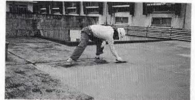
写真-2 平場部下地調整・ボンコートモルタル塗布
