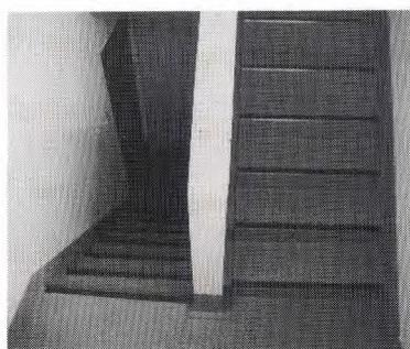
階段室床防水超速硬化ウレタン 施工後
