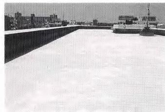
写真-5 下地処理完了
