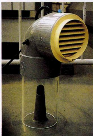
「サンシラール・ファン」は、改修工事の施工過程において従来の脱気筒、あるいは新たに設置した脱気筒の上に覆い被せて作動させることにより、強制的に空気の流れを発生させ、下地の乾燥を効果的に行うものです。
