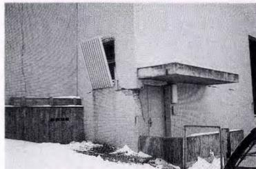
写真6 同 タイル剥落 亀裂
