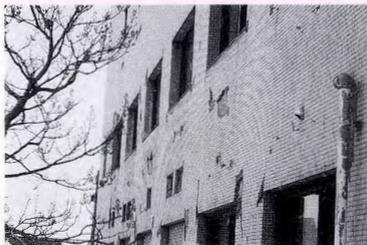
写真5 NTT八戸局 外壁部 タイル剥落
