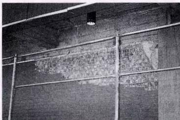
写真2 同 外壁部タイル剥落
