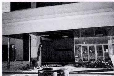
写真7 八戸市立八戸東高校校舎 柱破断
