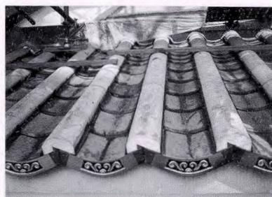
写真6 栗材、人工木材の固定及び銅板瓦の取付け
