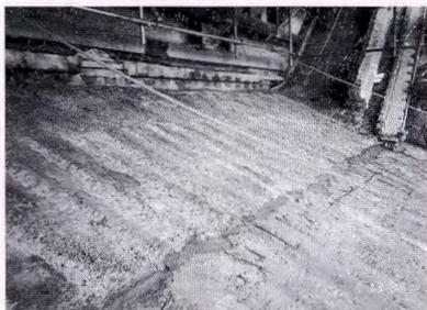
写真1 軽量モルタル施工前の下地
