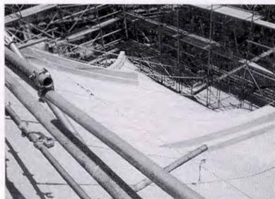
写真2 軽量モルタル施工後の下地
