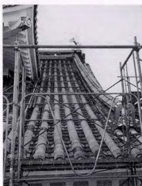
写真7 銅板瓦の取付け
