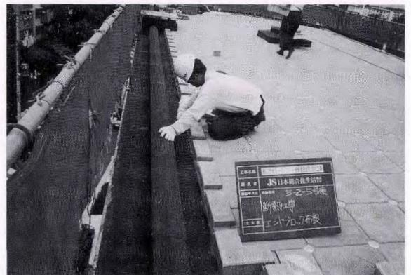
写真9 コンクリートブロック工法
