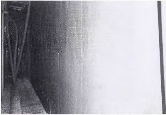
写真 a プライマー塗布後の状況
