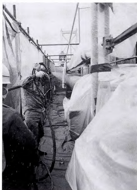
写真3 吹付作業風景
