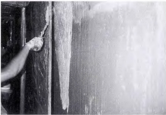
写真 b 下地調整材塗布状況
