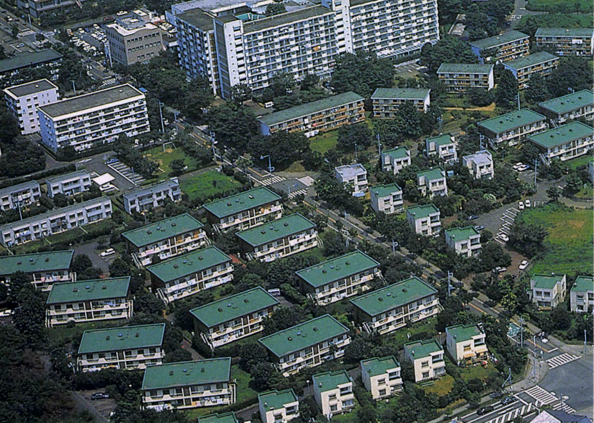
▲筑波竹園住宅 茨城県つくば市 19,700㎡ 田島ルーフィング㈱
