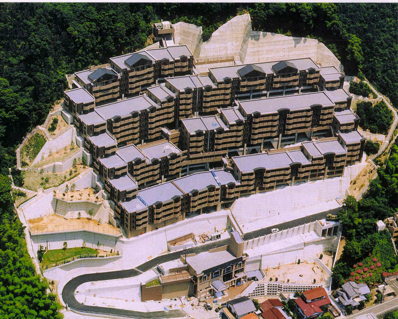
▼JGMウイングビル滑石 長崎県長崎市 5,392㎡ 保土谷建材工業㈱
