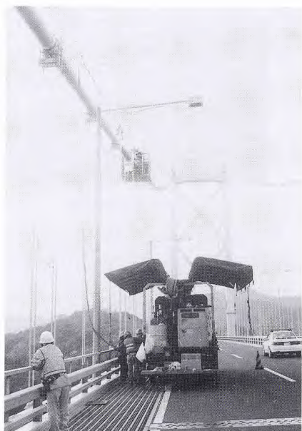
写真1 施工機械の設置。上方にゴンドラが見える
