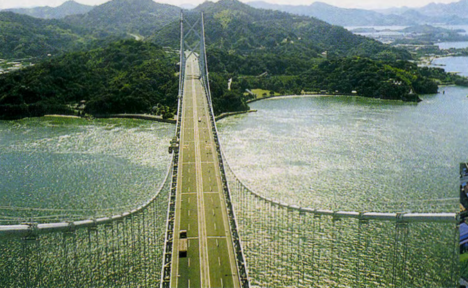
▲因島大橋主ケーブル 広島県因島市 240㎡ 三井化学(株)
