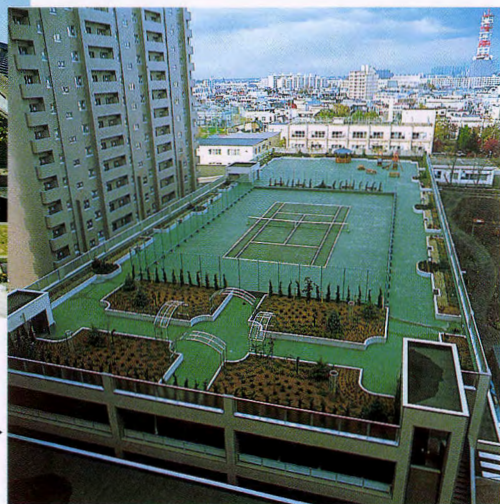
ラポール四季の杜 北海道札幌市 3,000㎡ 横浜ゴム㈱▶
