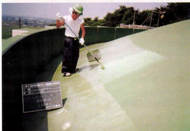
太田市郊外の高台にある水道施設。昭和60年に築造されたPCタンクの既存防水層は風雪や鳥害による劣化が進んだことから、施設保全のため屋根防水改修修繕工事を実施することとなった。
