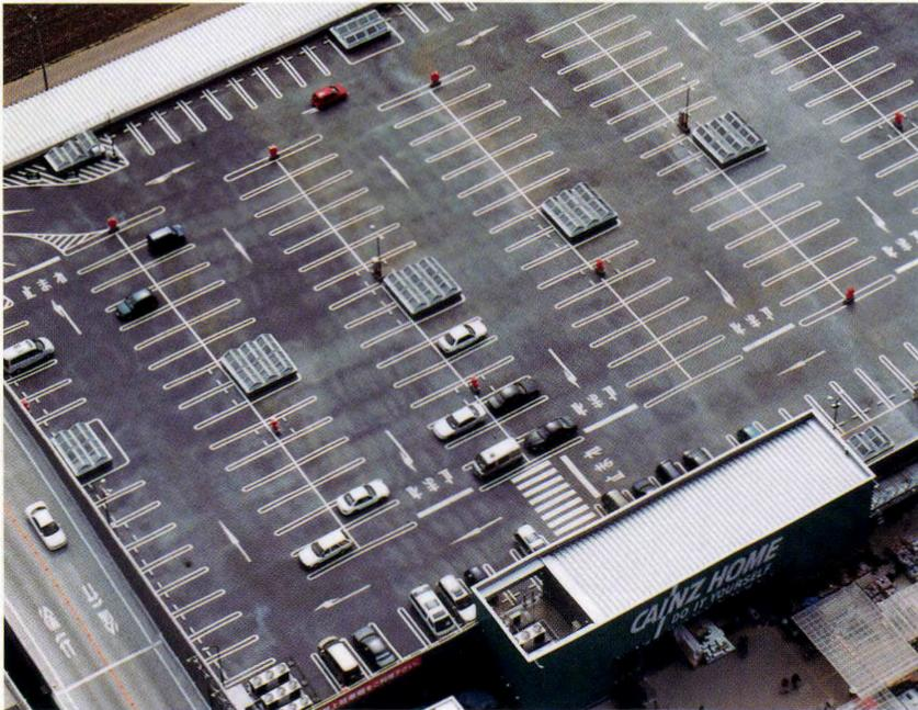
ショッピングセンター屋上駐車場防水床に汎用ウレタンと硬質ウレタンの複合工法で施工。
