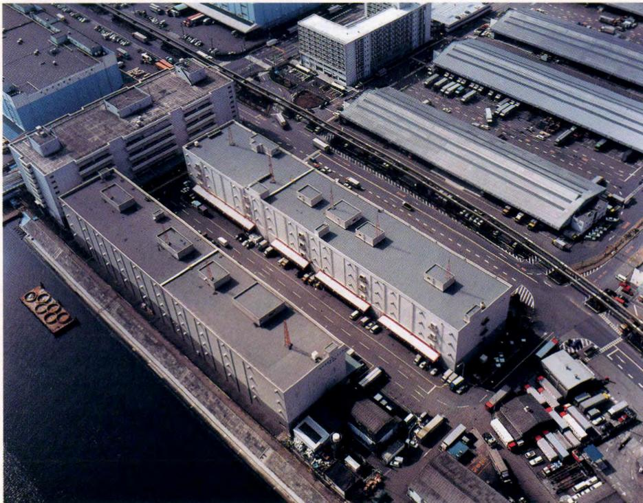
既存の保護押え層を撤去せず、いわゆるかぶせ方式で改修した。
