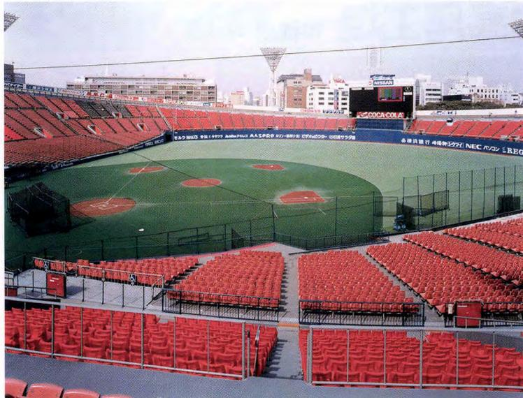
プロ野球ファンにはお馴染みのベイスターズのホームグラウンド。横浜の中心街に位置し、市役所・中華街も至近距離。従って、当該工事には工期の短縮と同時に周辺への配慮から臭いを出さない材料・工法が求められた。また、スタンドの下に居室があるため防水性能の点でも高性能、高耐久性が要請された。このような諸条件に応えられる仕様として屋上駐車場防水床で多くの実績を持つ汎用ウレタンと硬質ウレタンの複合工法が適用された。
