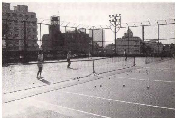
1980年に東中野の鈴木ビル(フィットネスクラブ)の屋根ALC下地に発泡ポリエチレンシートを敷き、防水層としてウレタンを2ミリ塗り、さらにスポーツ床材を塗って、屋上テニスコートとした。ウレタンの防水層と床材の複合工法の始まりであった。ムーブメントの大きいALC下地で、ウレタン防水と床材で屋上商業用テニスコートを可能にした。さらにこの建物の中は温水プールであり、ALC目地を通して防水層裏面にかかる蒸気圧を逃すことも兼ねていた。つまりここでの成功がウレタン防水層の膨れ防止工法への信頼に繋がったのかもしれない。
