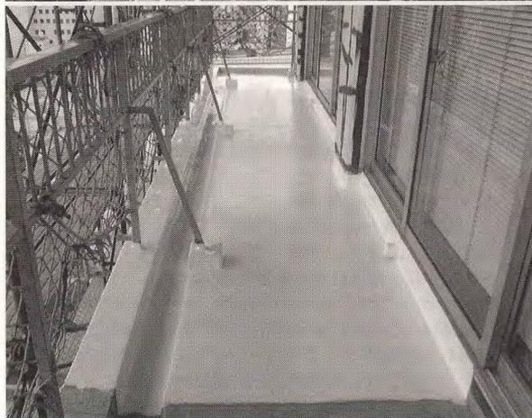
写真1 遮熱性能を付与したウレタン防水材
