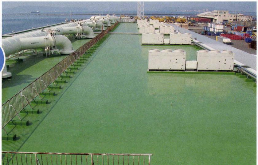
○既存ウレタン塗膜防水層の防水改修工事において、ウレタン塗膜防水によるオーバーレイ方法のため、既存防水層を撤去しないため、撤去作業による建物の損傷や産業廃棄物の低減が図れ、建物の長期耐久化にも役立ちました。
