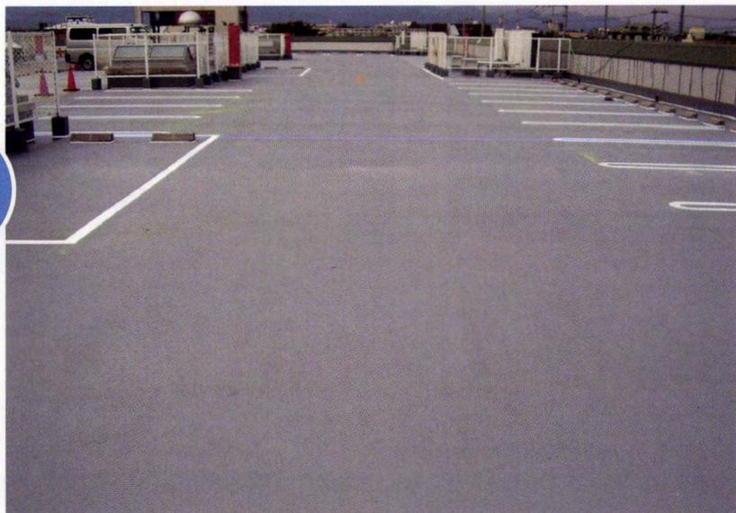
○駐車場の改修工事の事例ですが、既存の防水層は劣化が進んで、表層のひび割れや剥離が発生していたため、改修工事の計画が立てられました。
