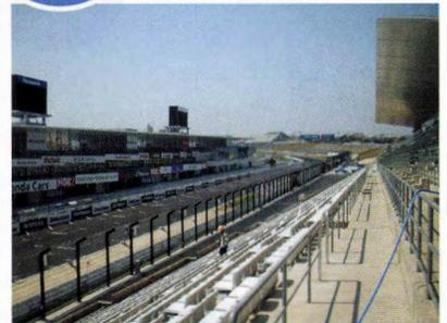
○この物件の原設計はPCとRCの複合構造で押え防水でしたが、竣工後の点検で目視検査ができメンテナンスの容易さということで露出防水が採用となりました。また、観客席という用途であることでウレタン防水の中でも特に物性の優れた超速硬化ウレタンが採用となり、短工期の実現と施工のスピーディーさで元請から高評価をいただきました。
