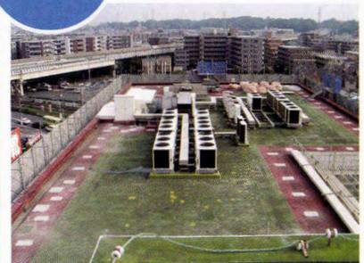
○新築時点では押えコンクリートの仕上げであったが、前回の改修工事でウレタン塗膜防水工法で施工されていた。
