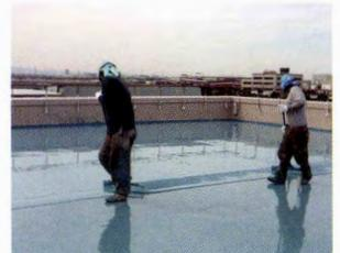
○既存押えコンクリート屋根は経年で傷みが発生しており、屋根も複数個所に分かれていた。一部の屋上には空調機器やポンプ機器などの設置物が多いことから、ウレタン塗膜複合工法が採用された。
