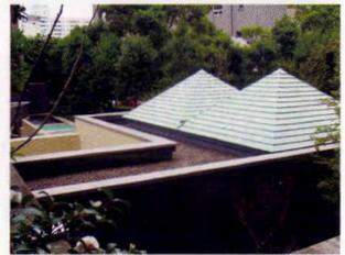
○この物件は大型マンションでの施工事例です。ウレタン防水が採用になった理由として防水施工箇所の仕様用途ごとに工法が対応できる点でした。既存が砂利押えアスファルト防水には植栽仕様、自走式ゴンドラ使用の屋上は駐車場仕様、大屋根は脱気絶縁工法、ベランダは密着仕様とマンション改修仕様の提案の仕様と用途が適切という判断をいただき採用となりました。
