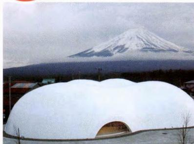
○設計事務所から屋根と外壁を分けることなく一体化した工法を探しているという要望を受け、ニーズに合致した超速硬化ウレタン（スプレー）が採用されました。仕上げには、水垢で汚れ無いように光触媒保護仕上塗料（トップコート）が採用されました。
