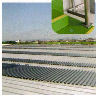
○観客席屋根は折板下地で、競輪場のオーバル形状になっていて、折板の構造上加工がしにくく、隙間が空き漏水していたそうです。(荷重もかけられないということで、)カバー工法では無く、軽量の超速硬化ウレタン（スプレー）が採用になりました。
