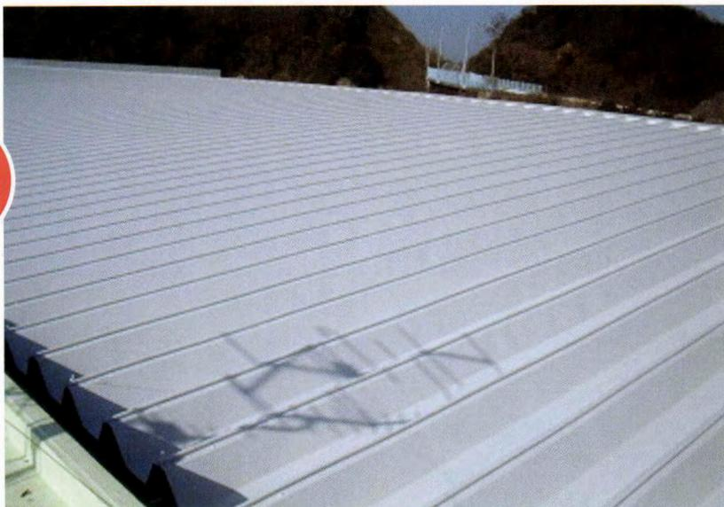
○軒樋部からの漏水改修と併せ金属屋根の美装を目的とし、塗装より長持ちする仕様の提案を求められ採用されたものです。屋根部に発錆・金属部の変形・室外機の処理・壁面との取り合い等の問題もクリアし、施主及び元請けからも仕上がりの美しさに賛辞をいただいた物件です。
