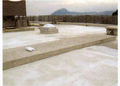
○既存下地が、アスファルト防水押えコンクリート仕上げであったために、工法は通気・緩衝工法が採用され、立地場所が温泉地であるために耐薬性をふまえて、高耐薬性、高耐候性のフッ素保護仕上塗料（トップコート）が採用されました。
