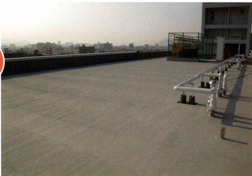
○既存下地がアスファルト防水砂付ルーフィング仕上であったため、撤去により発生する産業廃棄物の削減、施工時の漏水リスク低減を考慮し、機械固定工法が採用されました。また、居住環境改善のため遮熱保護仕上塗料（トップコート）を採用していただきました。
