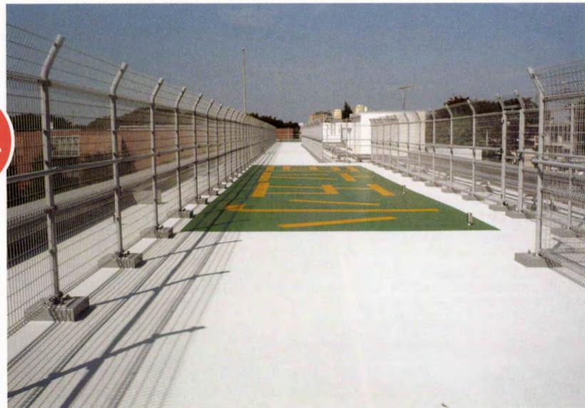
○既存押えコンクリートには経年による割れ等劣化が進行しており、伸縮目地には雑草が生育しているなど、屋上屋根の防水層に影響を及ぼす状況にありました。改修後も屋上利用があることからウレタン塗膜複合防水工法を提案し、更にヘリサイン（再帰性反射フィルム貼り）の提案も行って採用されました。
