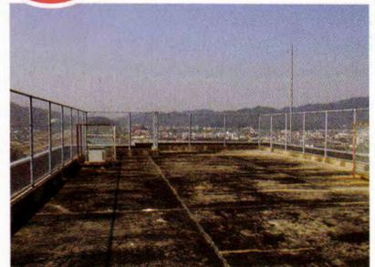
○既存下地はアスファルト防水押えコンクリート仕上げで、経年で汚染と風化が進行していました。長期耐久性と美観向上を考慮し、通気緩衝工法のフッ素保護仕上塗料（トップコート）をご採用いただきました。
