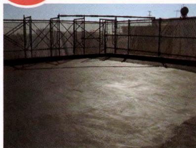
○既存防水層は押えコンクリートで経年劣化が進んでいたため、ウレタン塗膜防水材の通気緩衝工法、また遮熱性能を付与した高耐候性高日射反射率遮熱塗料(トップコート)をご提案してご採用いただきました。
