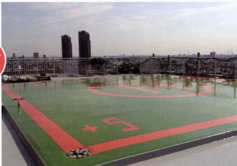
○この建物は高層のマンションで新築時は押えコンクリート仕上げでした。改修防水工法としてウレタン塗膜複合防水工法+災害用ヘリサインフィルムをご提案してご採用いただきました。
