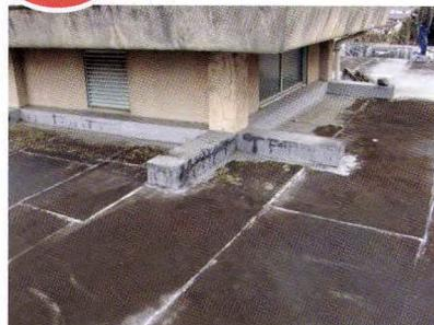
○既存防水には様々な塗膜防水が施工されていたので、下地を選ばない非常に便利な工法として、自着層付通気緩衝シート脱気絶縁複合法をご提案してご採用いただきました。
