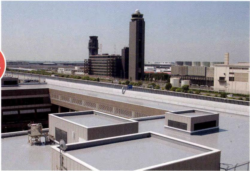
○新築時は押えコンクリート仕上でしたが、約10年前にウレタン塗膜防水工法にて改修工事を実施し、今回が2回目の改修工事となりました。既存のウレタン塗膜防水の上からかぶせ施工する増し塗り工法をご提案してご採用いただきました。
