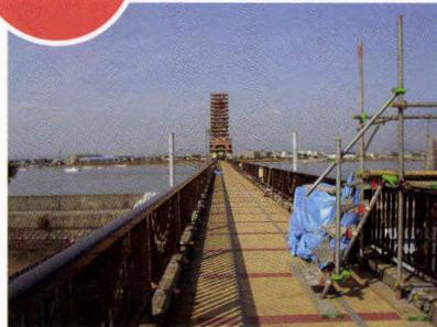
○以前は鉄道の橋でしたが、廃線後の現在は重要文化財・機械遺産となり遊歩道となっています。橋梁保護のために歩行可能な防水材料としてウレタン塗膜防水工法をご提案してご採用いただきました。
