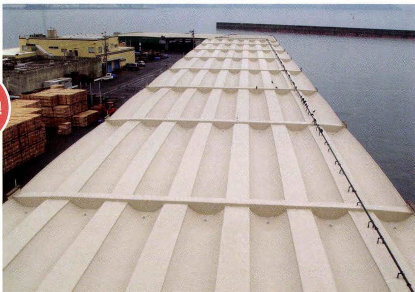
○既存シート防水が剥離し、漏水している状況でした。改修仕様として特殊形状屋根にでも均一な厚みが確保でき、長期的に防水層を維持できる工法として、超速硬化ウレタン吹付け工法 非破壊塗膜管理システム ハルスハイブリット系遮熱保護仕上材をご提案してご採用いただきました。
