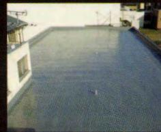
機械的固定工法 外断熱
