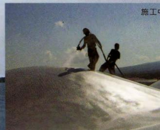
機械化コントロール・超速硬化ウレタン防水システム
