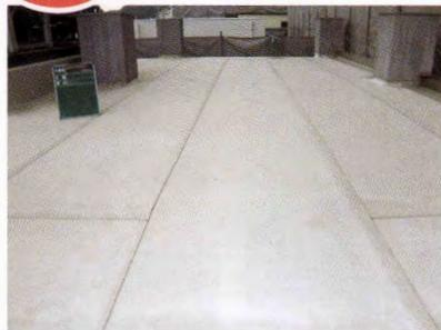
○機械室屋上は既存下地がシート防水材であったため、既存防水層の撤去が最小限で済む機械的固定工法をご提案してご採用いただきました。また、工事全体として役物が多いことを考慮し、ウレタン防水層には施工性に優れた超速硬化ウレタン(スプレー)をご提案してご採用いただきました。
