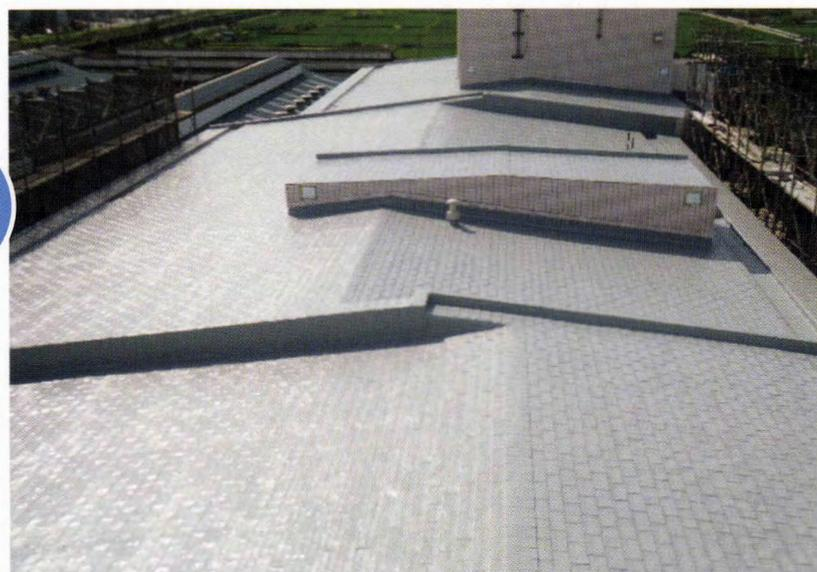
○既存防水は、アスファルトシングル葺き屋根でした。アスファルトのかぶせ工法より、ライフサイクルコストを考慮した結果、次回改修が実施しやすいウレタン塗膜防水で提案しました。更に既存防水層を撤去する手間を削減する為に、超速硬化ウレタンエア混入システムを提案してご採用しました。
