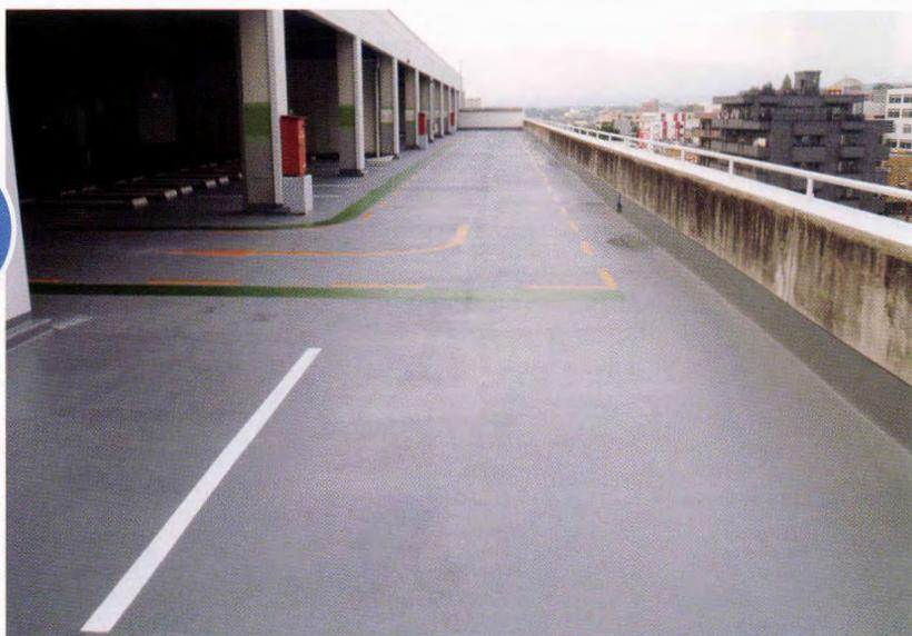
○昨今、駐車場の防水改修工事が増加傾向にあります。本現場も竣工時より10年以上経過したため既存防水層の経年劣化が進行しておりました。軽量で車両走行可能な高強度ウレタン防水床工法を提案してご採用いただきました。お客様の往来のある中、施主様のご協力得て、通行止めおよび汚染防止に努め、施工の管理を行いました。
