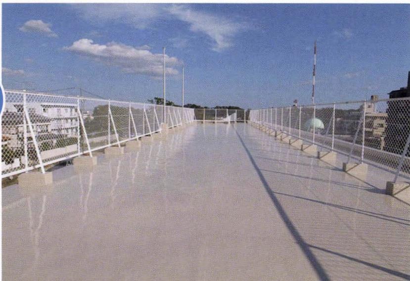
○ 耐震補強工事の一環で、既存露出アスファルト防水の改修工法として、密着ウレタン防水工法で耐候性と遮熱性を考慮した保護仕上塗料であるフッ素系遮熱仕上材を提案して採用いただきました。
