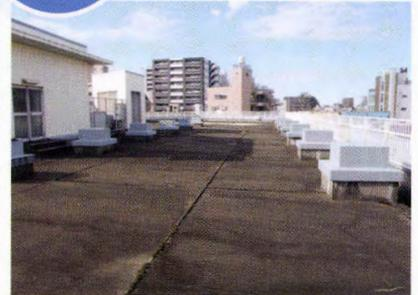
○採用の背景：新築時は押えコンクリート仕上げでした。改修防水工法としてウレタン塗膜複合防水工法+災害用ヘリサインフィルムを提案してご採用いただきました。
