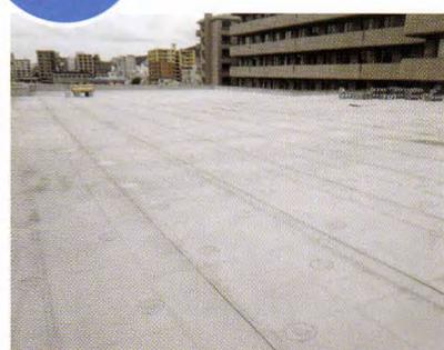
○既存の塩ビシート防水を撤去せずにオーバーレイで改修する方法として、ブチルゴム粘着層付の脱気絶縁シートで塩ビシートとの接着力を確保し、その上にウレタン防水を施工する複合工法を提案してご採用いただきました。また、火気に対する耐久性を求められていましたので、表層の仕上げは無機質系のトップコートを使用しました。ウレタン塗膜防水工法の多機能性が発揮できた例の一つです。
