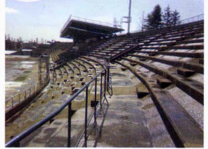
○観覧席が平面と立面の複雑な階段状のために、均一な厚みの確保と工期短縮から超速硬化ウレタン吹付工法を提案してご採用いただきました。
