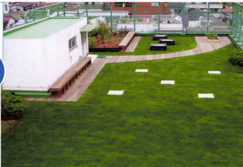
○ 小学校の改修工事のなかで、緑化する屋上は耐根シート不要の超速硬化ポリウレタ複合塗膜防水工法を、開放スペースとして使用する屋上にはX-2工法と蛍光塗料を使用したヘリサインを採用いただきました。耐根シートがいない塗膜防水のため、水密性に優れ、改修後のメンテナンス性にも優れることが採用の決め手となりました。ヘリサインは塗材なので、ウレタン塗膜防水層とよくなじみ、児童が運動する場所でも適切であると判断頂き、ご採用いただきました。
