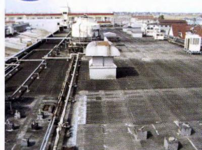
○採用の背景：既存は加硫ゴムシート防水でしたが、稼働中の工場の屋根のため動かさない設備機器が多くあることから、移設なしで立上り端部まで防水施工が可能なウレタン塗膜複合防水工法を提案してご採用いただきました。
