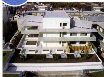
○医療系複合施設新築工事にて露出部、緑化部分を含め全面的にウレタンスプレー工法を提案して採用いただいた施設です。主な採用理由としては、信頼性の高い複合防水であることに加え機械化施工による工期短縮が可能であったことが挙げられます。
