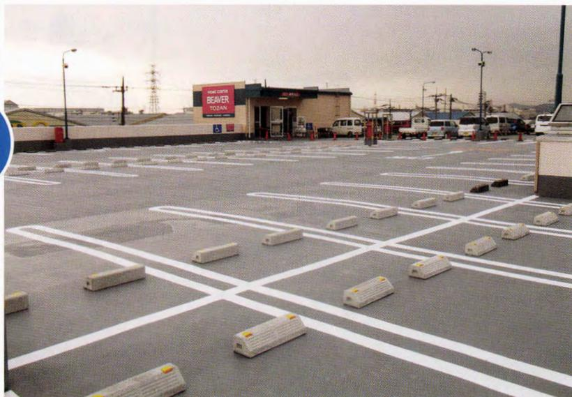
○昨今、駐車場の防水改修工事が増加傾向にあります。車両走行箇所の磨耗が進行していた為、同工法による増し塗り工法を提案し、ご採用いただきました。お客様の往来のある中、施主様のご協力得て、通行止めおよび汚染防止に努め、施工の管理を行いました。
