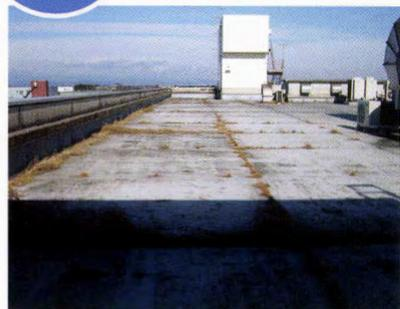
○既存アスファルト防水施工後 20 年以上経過しており、雨漏りする前に塗り替えとの事。ウレタン塗膜防水 (平場 X -1、立上り X -2 工法) を推奨してご採用していただきました。
