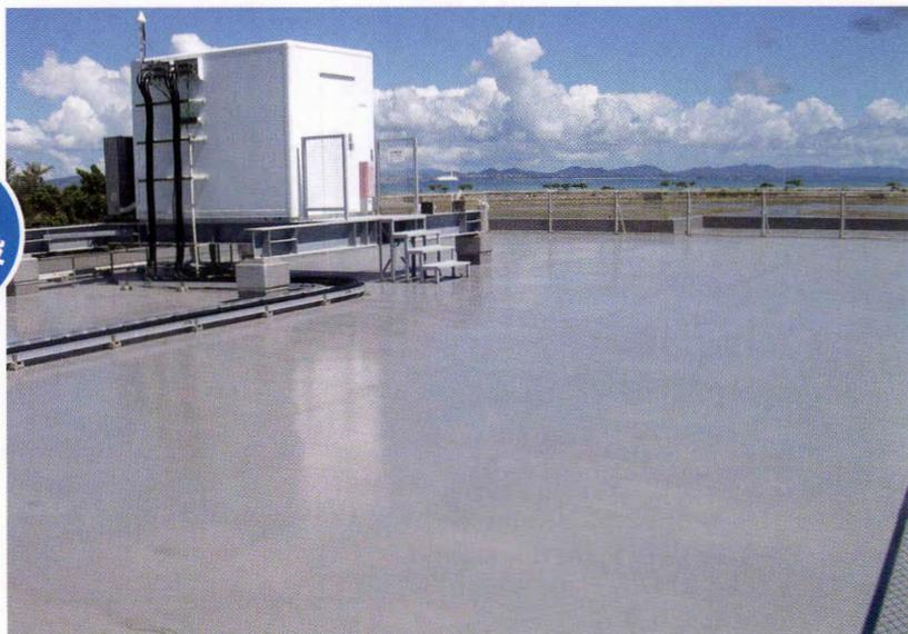
○既存防水はゴムシート防水でジョイント部の剥離が進行していた事から、シームレスな防水層が形成できるウレタン防水を提案してご採用いただきました。
