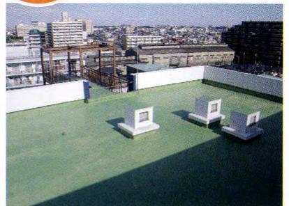
○大規模修繕工事に於いて、既存防水に引き続き、ウレタン塗膜防水通気緩衝工法をご採用頂きました。
