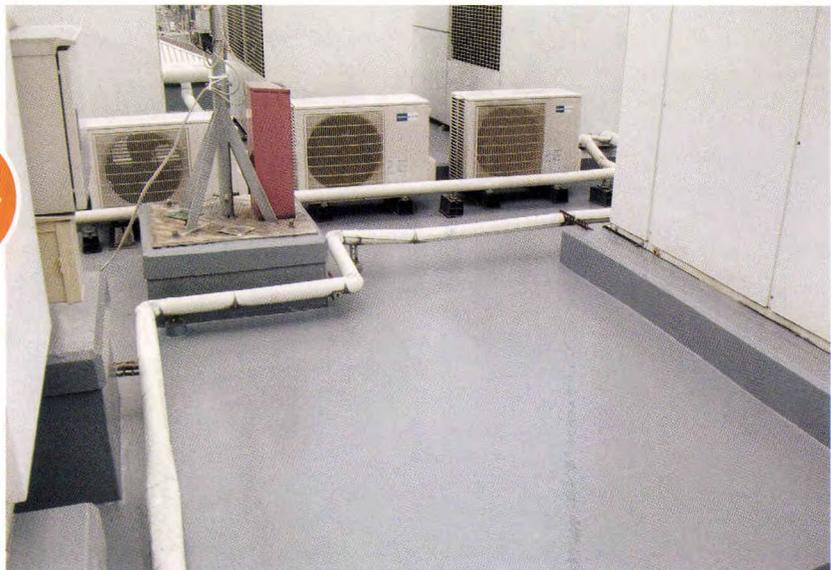
○既設にて室外機や配管等があり、施工箇所が複雑な形状でしたが、ウレタン防水はそのような箇所でも継ぎ目のない防水層を形成できる旨提案し、密着（補強布入り）工法でご採用頂きました。
