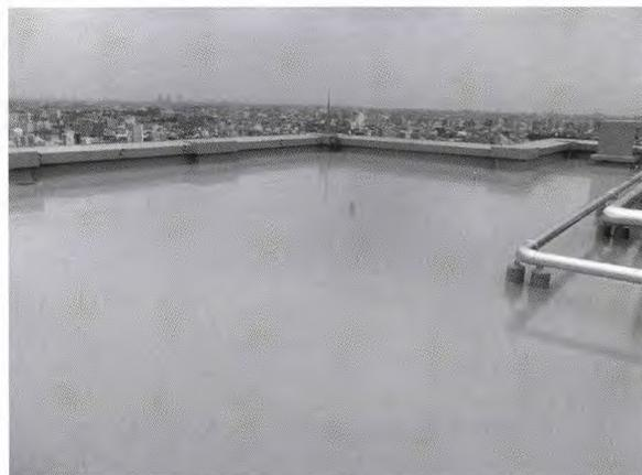
写真6 屋上防水改修における通気緩衝工法
