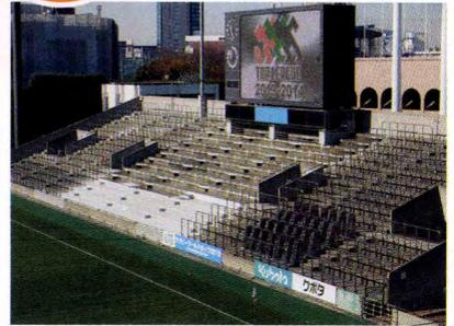
○競技場のスタンドは平面、立上面の連続複雑形状であること、施工工期の問題、不特定多数の出入りを考慮して、高強度、高耐久の超速硬化ウレタンに高耐候性保護仕上材を提案しご採用頂きました。
