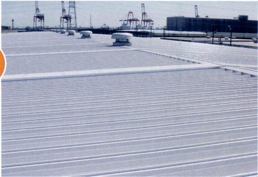
○倉庫内の温度を下げる為、遮熱塗料による遮熱効果を重点的にPRして、吹付型のウレタン防水材に遮熱塗料を組み合わせ提案しご採用頂きました。
