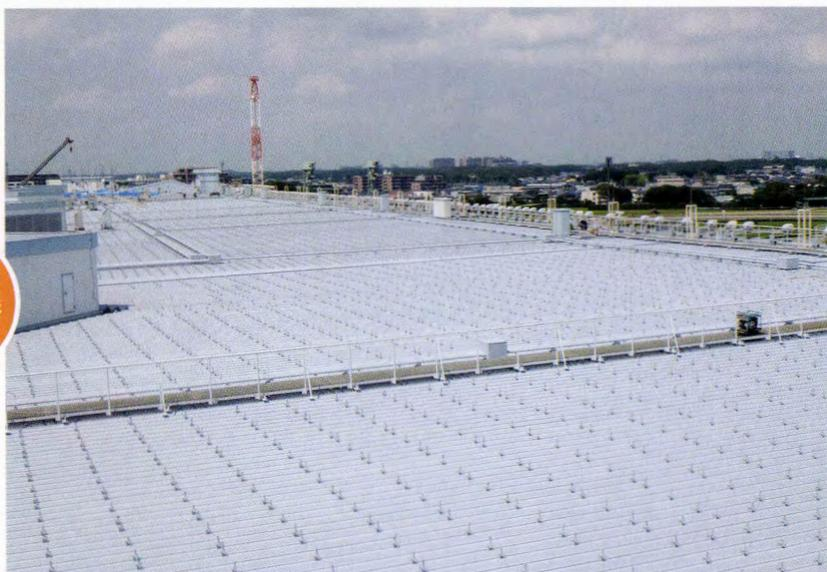
○金属屋根ですが漏水の発生があり、耐久性向上と屋根温度低下等の要望がありました。超速硬化ウレタン塗膜防水工法の高耐久性と遮熱性能を併せ持った保護塗料を提案して採用されました。
