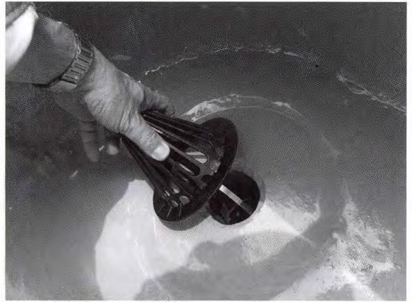
写真 11 改修用ドレンを用いた落とし口廻り
