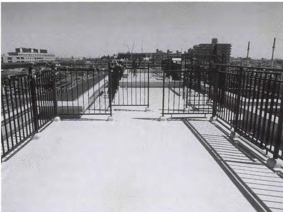
写真1 屋上防水の改修工事で、ウレタン防水を全面に行っている例。押さえコンの上に通気緩衝工法で施工中。(トップコート施工前)
