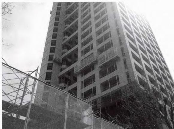
写真 12 ゴンドラを用いた超高層マンションの大規模修繕
