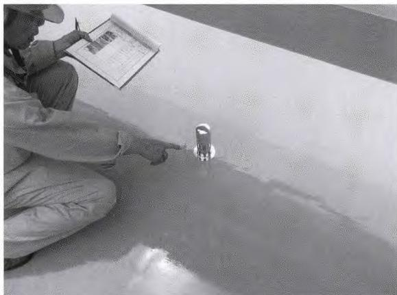
写真7 通気緩衝工法を行う際に設けた脱気筒
