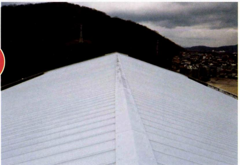
○既存金属屋根に漏水が発生していましたが原因特定が困難であることから、超速硬化型吹付ウレタン塗膜防水工法での全面施工を提案して採用されました。
