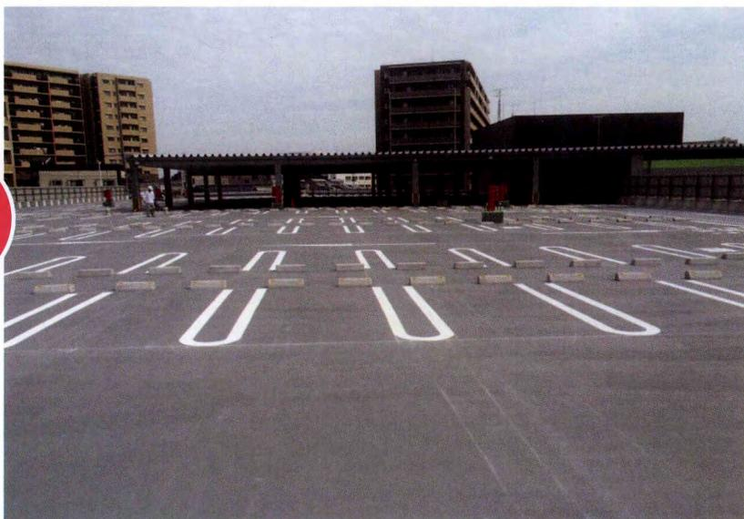
○防水層が軽量であり構造体への負担軽減、施工の手軽さと25年以上の施工実績から、高強度ウレタン塗膜防水駐車場工法を提案して採用されました。
