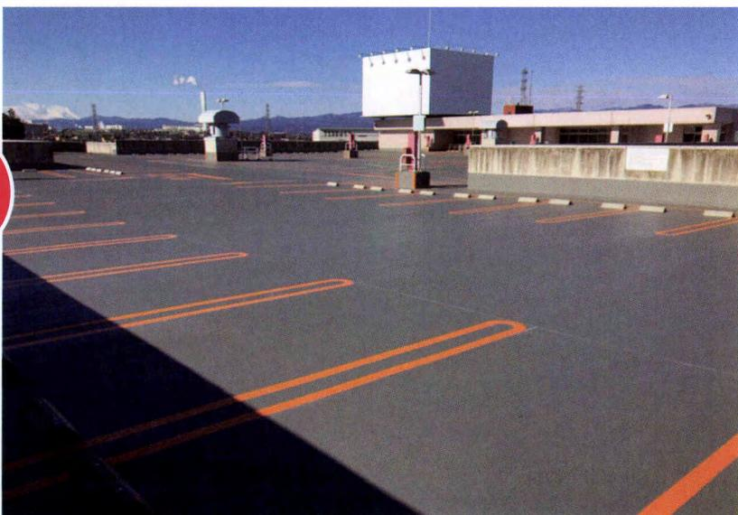
○既設はウレタン塗膜防水駐車場仕様で経年劣化が進行していました。工期短縮、低騒音を要望されたことから、既設との接着性に優れたウレタン塗膜防水駐車場仕様で上からかぶせて施工する工法を提案して採用されました。
