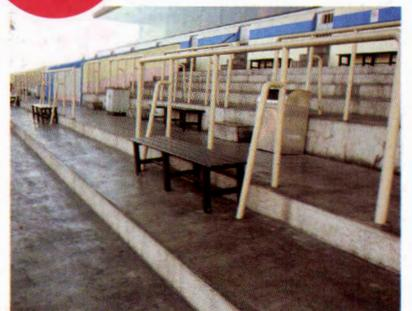
○工期が短い上、施設を使用しながら改修工事を行うとの条件で施工可能な時間が限定されていました。仕上りの美観や耐久性も求められ、超速硬化型吹付けウレタン塗膜防水工法を提案して採用されました。
