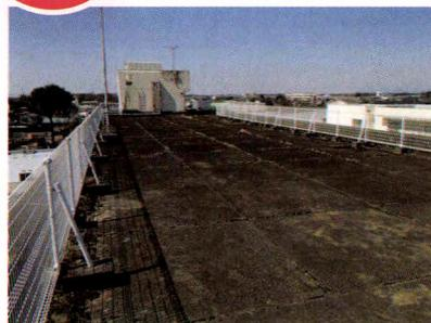
○既存は押えコンクリートで、既存フェンス及び基礎を残して改修することが条件だったため、施工性と水密性に優れたウレタン塗膜防水とし、平場は押えコンクリートの動きと下地に含まれる湿気を考慮して絶縁工法を提案して採用されました。
