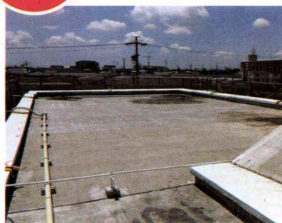
○既存防水が露出アスファルト防水でしたが、非撤去にてウレタン塗膜防水を施工の上、居室内の温度を抑制するために高反射塗料仕上を提案して採用されました。
