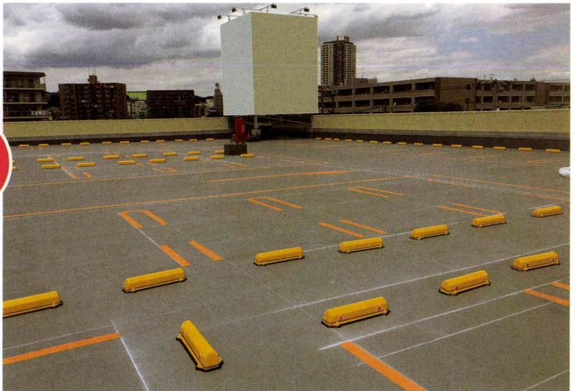
○ 防水層が軽量であり構造体への負担軽減、施工の手軽さと 25 年以上の実績から高強度ウレタン塗膜防水駐車場工法を提案して採用されました。
