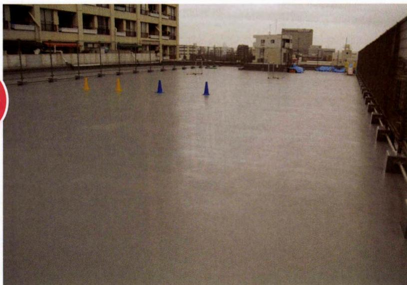
○屋上に植栽があり、現在漏水が激しく既存の押え層の状態も悪い為、既設アスファルト防水まで全て撤去し、下地を作りなおして施工した物件です。
