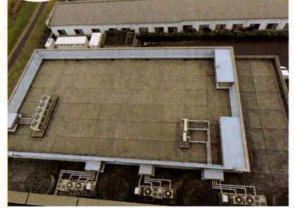
○空調機等の架台と配管が多いことから、シームレスな防水層を形成できるウレタン塗膜防水が最適と判断されました。既設は押えコンクリート下地のため、下地の挙動や水蒸気圧による影響を考慮し、絶縁工法を提案して採用されました。
