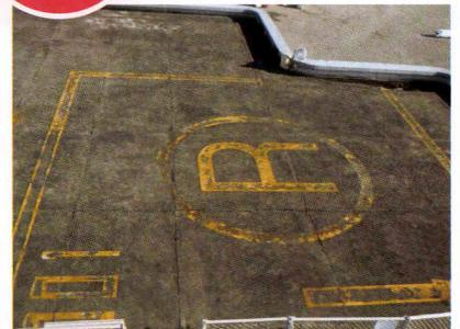
○既存はアスファルト防水押えコンクリート上へペイントでヘリサインが施されていました。非撤去で軽量・シームレスのウレタン防水通気・緩衝工法と、再帰性反射フィルムタイプのヘリサインの組合せを提案し、採用されました。
