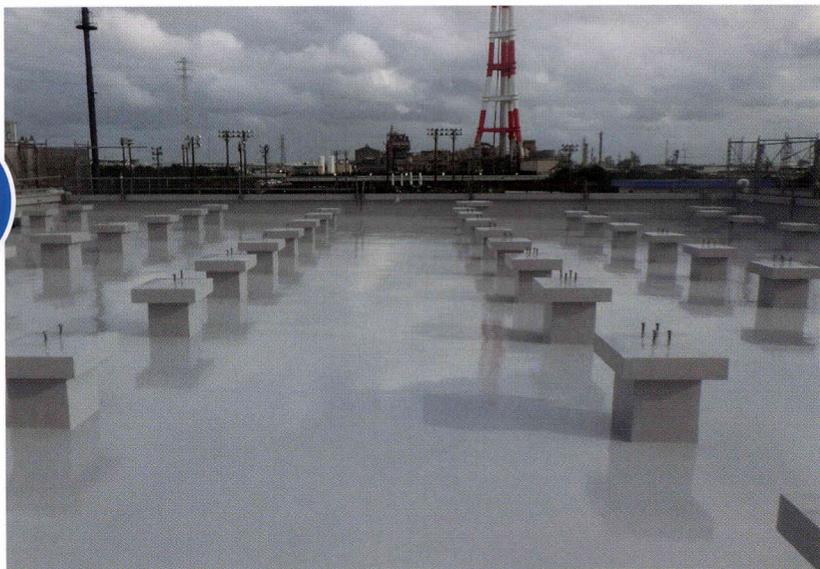
○ゼロ・エネルギー・ビル（ZEB）です。ソーラーパネルの設置や、50mm厚ウレタンボード敷設による高断熱化など、『創エネ・省エネ・蓄エネ』を考慮した工夫が多く採用されています。多い架台に対応するため、役物に強いウレタン塗膜防水が採用され、外断熱・機械的固定工法で施工されました。
