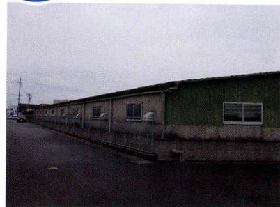
○車庫兼倉庫のスレートの外壁及び屋根の美観改善と防水対策として環境対応型1液ウレタンコーティング材の施工を行いました。屋根部分は高反射色のトップコートを使用して夏季の居住性の改善提案も行いました。全行程吹付け施工により工期短縮がはかれ、綺麗な仕上がりとりました。
