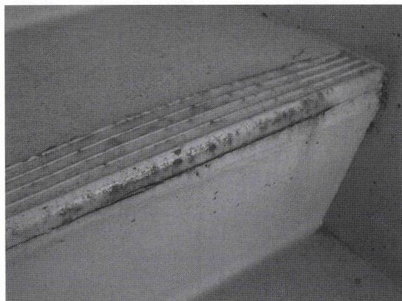
ノンスリップ金物上に超速硬化型ウレタン塗膜を
