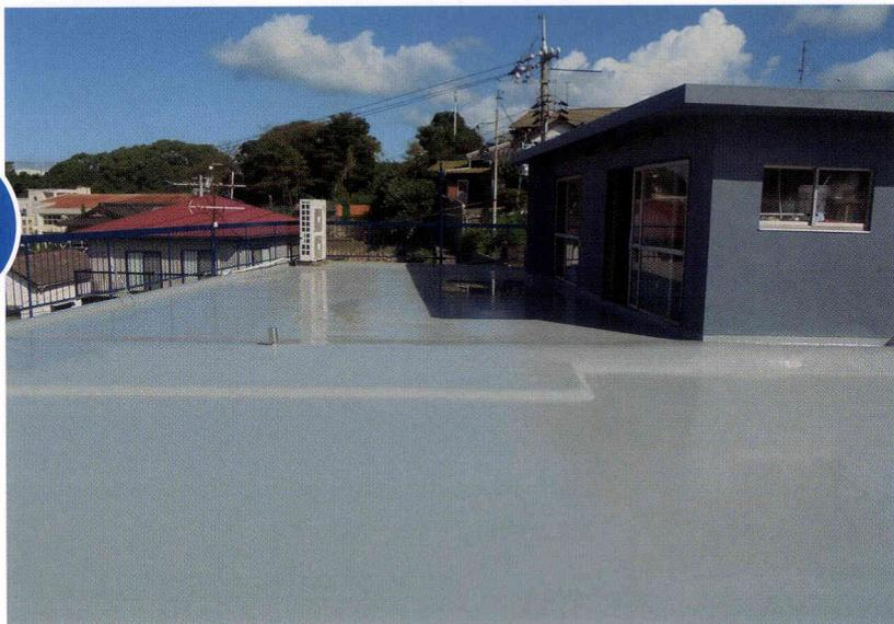
○ウレタン密着工法が施工してあり膨れ、雨漏りが酷くなった為、ウレタン塗膜絶縁工法を提案し採用されました。
