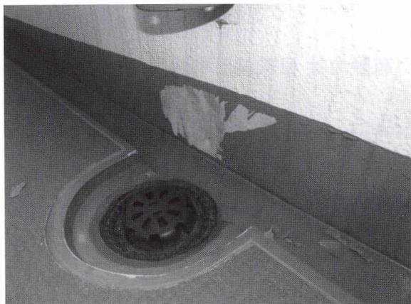
トップコートのみで剥離し躯体が露出した例
