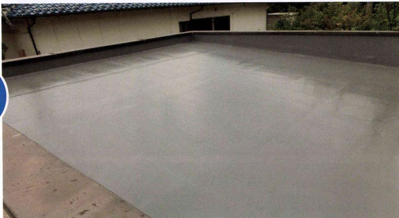
○既存がウレタン塗膜防水であり、工期短縮、省力化の要望があったため、1成分形ウレタン塗膜防水材と1日で施工完了可能な硬化促進剤を組み合わせた工法を提案し、採用されました。
