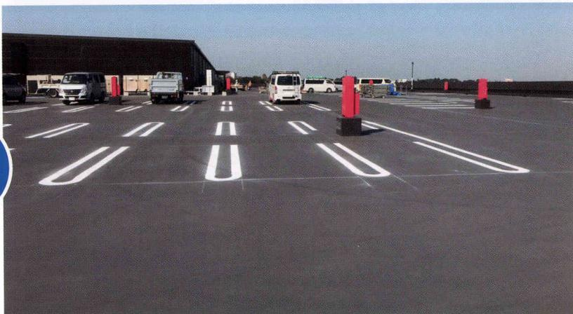
○防水層が軽量であり構造体への負担軽減、施工の手軽さと25年以上の実績から高強度ウレタン塗膜防水駐車場工法を提案して採用されました。
