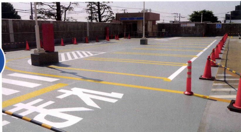
○水膨れに伴う塗膜の剥離が進行していたため、水分上昇を遮水する下地処理材を提案し採用されました。
