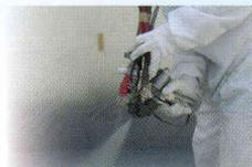
「超速硬化」のウレタン塗膜を「スプレーで成形する」超速硬化ウレタン吹付けシステムのパイオニア。塗布後短時間で実用強度を得ることができるため、作業時間を大幅に短縮できる。複雑な形状にも連続的に施工が可能。
