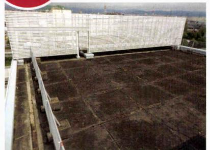
○屋上に空調設備等が多数設置されていることからシームレスな防水層が形成できるウレタン塗膜防水が採用されました。既存下地はアスファルト防水押さえ工法で、下地の影響軽減の為、絶縁工法が採用されました。
