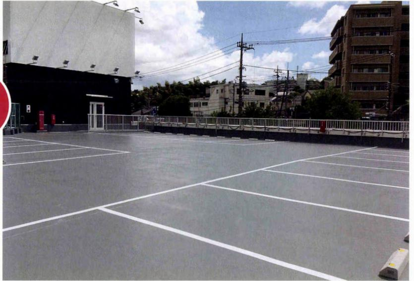
○新築時にFRP防水層が採用されておりましたが、改修時には施工の手軽さと実績から高強度ウレタン塗膜防水駐車場工法が採用されました。
