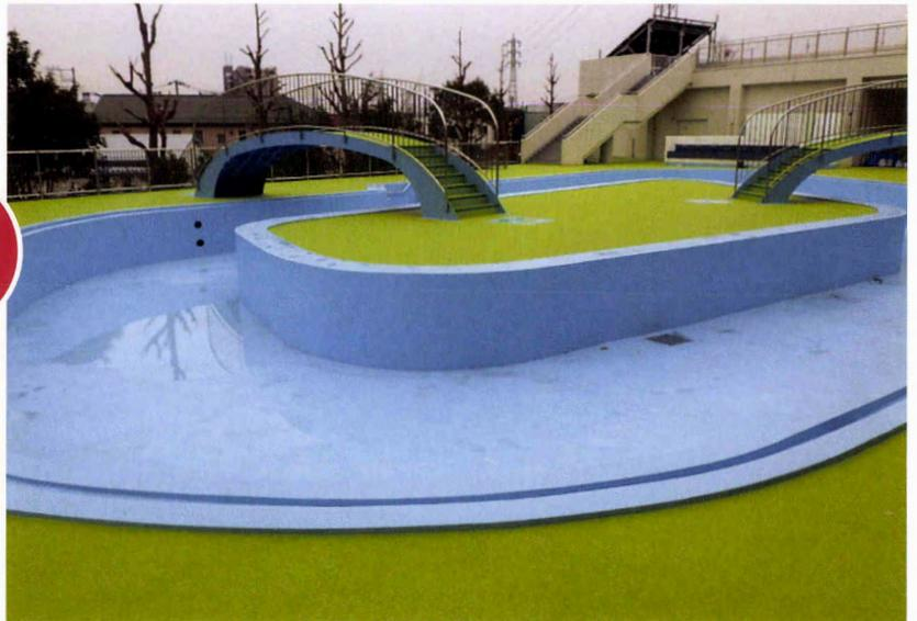
○高強度・高耐久が特長の超速硬化ウレタンの施工を提案して採用されました。既存コンクリート下地の塗装材を撤去・研磨後、ピンホール対策に手塗ウレタンを塗布してから超速硬化ウレタンをスプレーしました。
