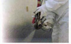
「超速硬化」のウレタン塗膜を「スプレーで成形する」超速硬化ウレタン吹付けシステムのパイオニア。塗布後短時間で実用強度を得ることができるため、作業時間を大幅に短縮できる。複雑な形状にも連続的に施工が可能。
