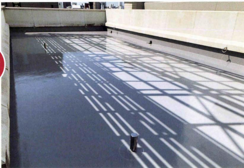
○既存防水が加硫ゴムシート断熱工法であり、ホテルの営業を継続しながらの施工となるため、作業音を最小限に抑えつつ断熱性能を維持復旧することが可能なウレタン塗膜防水絶縁断熱工法が採用されました。
