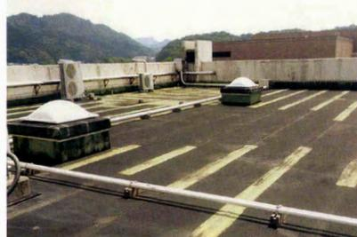
○改修前はゴムシート防水の建物でしたが、撤去工事、発生残材の低減などの観点から、ウレタン塗膜防水の機械固定工法が採用されました。
