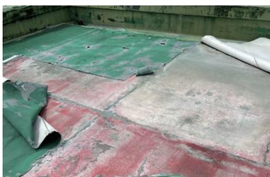
○既存防水層は、ウレタン塗膜防水絶縁工法が施工されていましたが、経年による通気緩衝シートの劣化があったため、既存防水を撤去の上ウレタン塗膜防水絶縁工法を提案し、採用されました。
