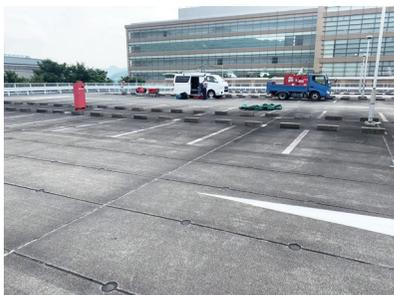
○防水層が軽量であり、かつ建物への負担軽減、さらに信用度の高い施工実績から「超速硬化ウレタン吹付けシステム」の駐車場工法が採用されました。
