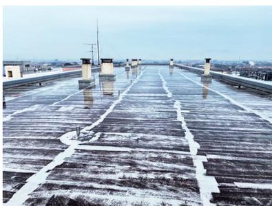
○既存がウレタン塗膜防水であったことから、施主は同じ仕上げのウレタン塗膜防水での改修工事を希望されました。下地が悪かった為、機械固定工法を採用頂きました。
