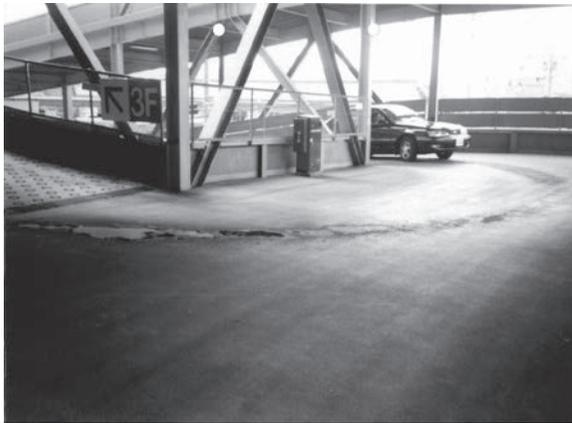
写真5 駐車場防水層の摩耗と剥離
