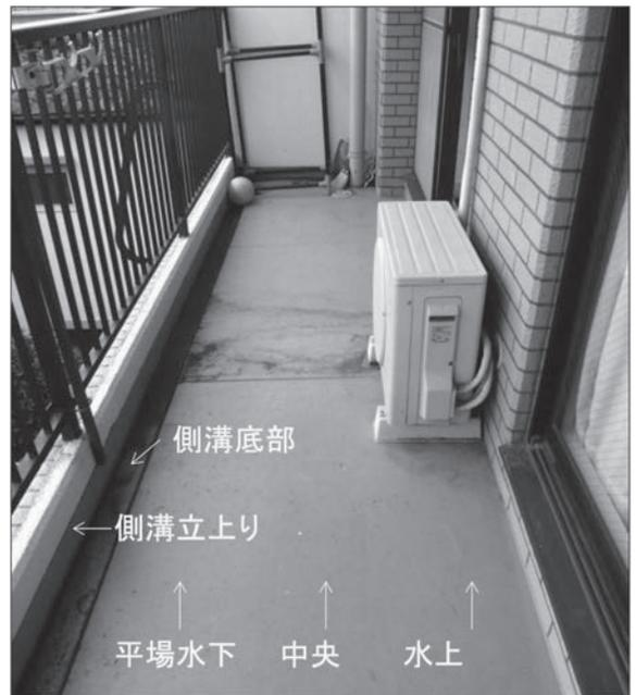
写真 18 防水層の厚さ測定位置
