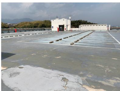
○屋上駐車場防水の劣化が激しく漏水があり、施主・元請・施工店・製造会社で現場確認しながら商品の特長や仕様、注意点を説明することで、超速硬化型ウレタンスプレー工法が採用されました。
