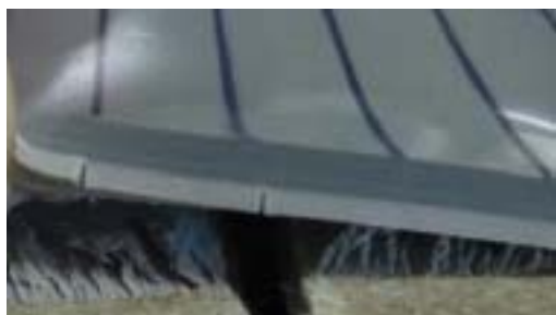
図 4 試験体② ひび割れ試験後
